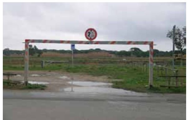
Esempi di impiego non corretto di sbarra ad altezza ridotta dalla sede stradale con divieto di transito per altezza
